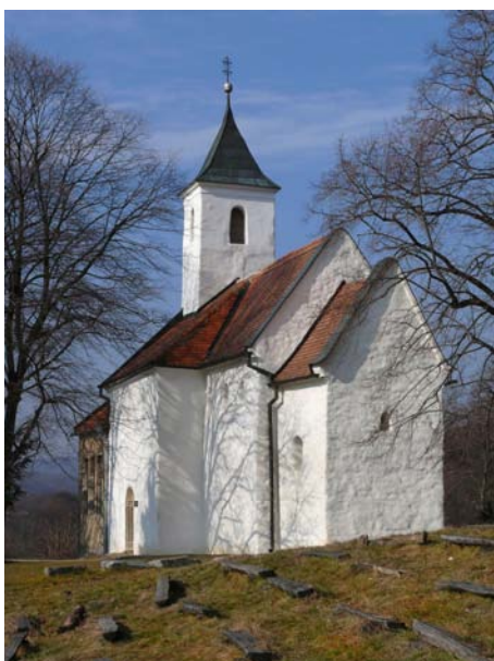
2. IGLESIA DE SAN JORGE DE KOSTOĽANY POD TRIBEČOM FOTOGRAFÍA ANEXO 1. VISTA GENERAL DEL MONUMENTO
