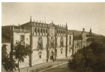
Figura 4. Fachada de la Universidad de Alcalá de Henares desde la plaza de San Diego. Vistas desde la ventana de la casa familiar.
