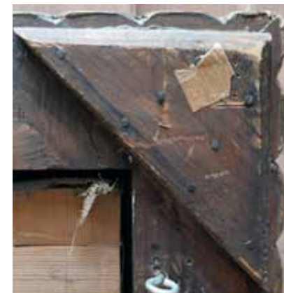
Fig. 15a. Detalle del refuerzo en los ingletes
