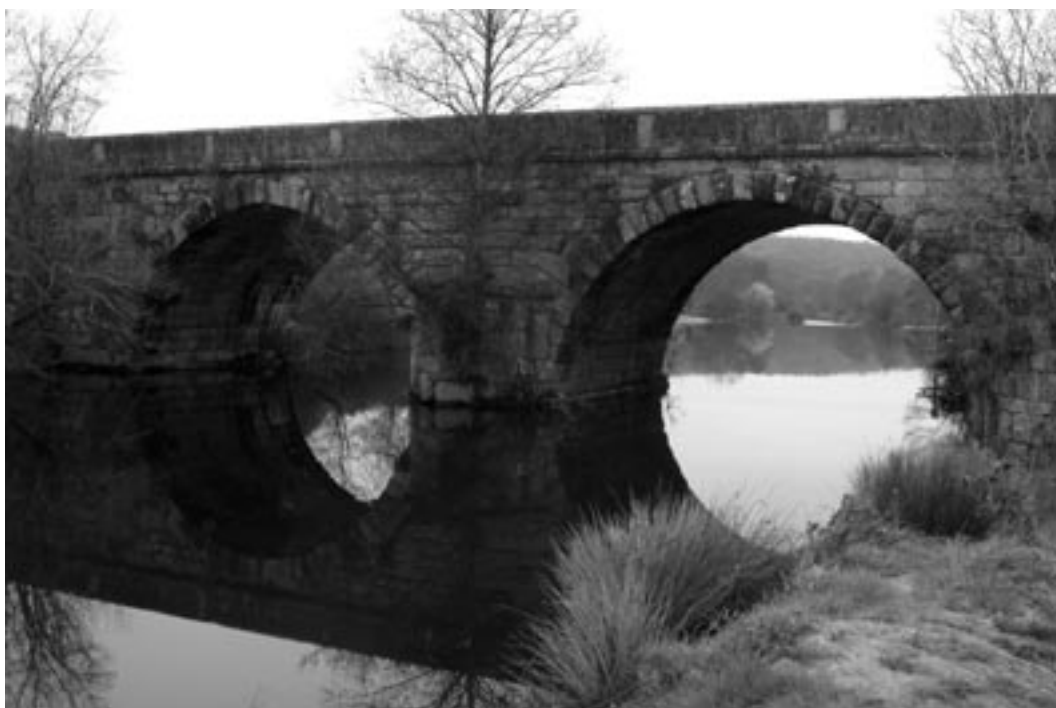
Fig. 4. Puente romano de Cáparra (Cáceres), visto desde la cara correspondiente a las aguas arriba del río. © Los autores.
