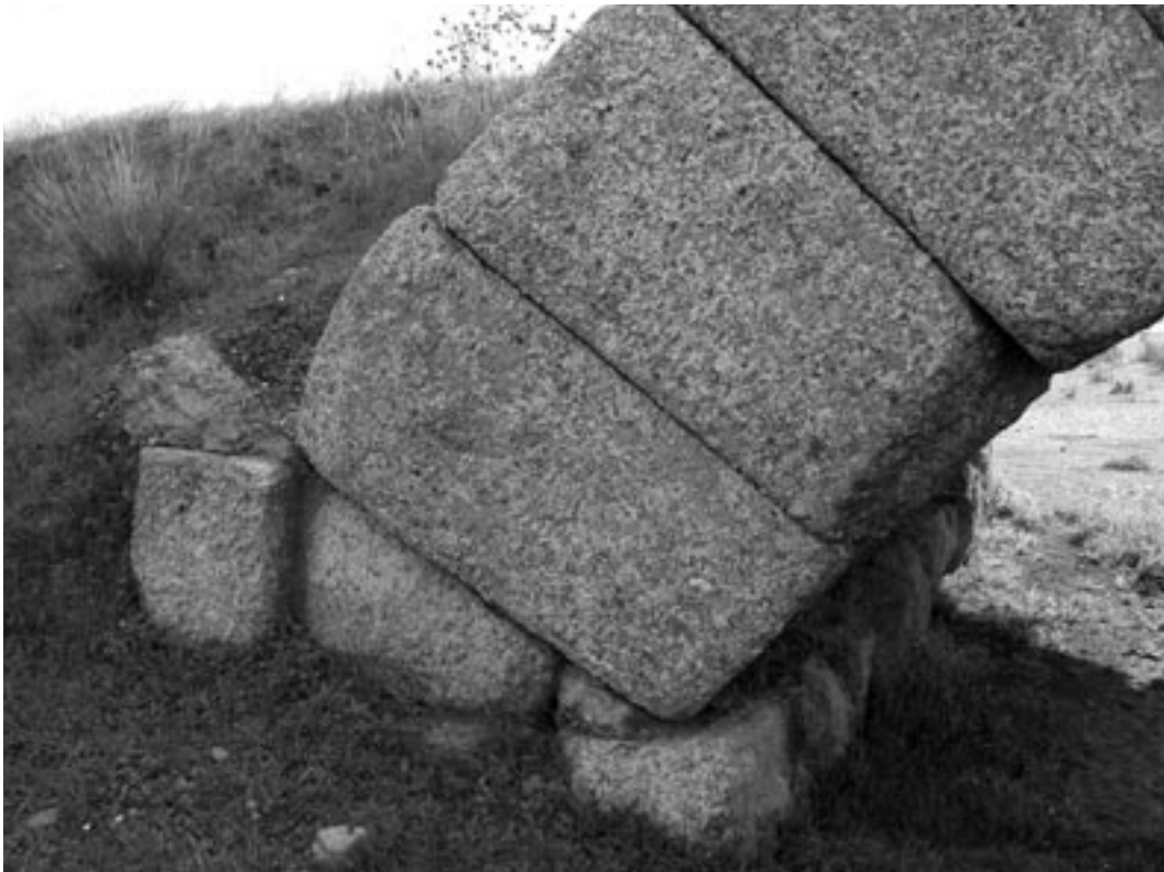
Fig. 7. Puente de Alconétar (Cáceres). Arranque de uno de los dos arcos escarzanos que se mantienen de época romana. © Los autores.
