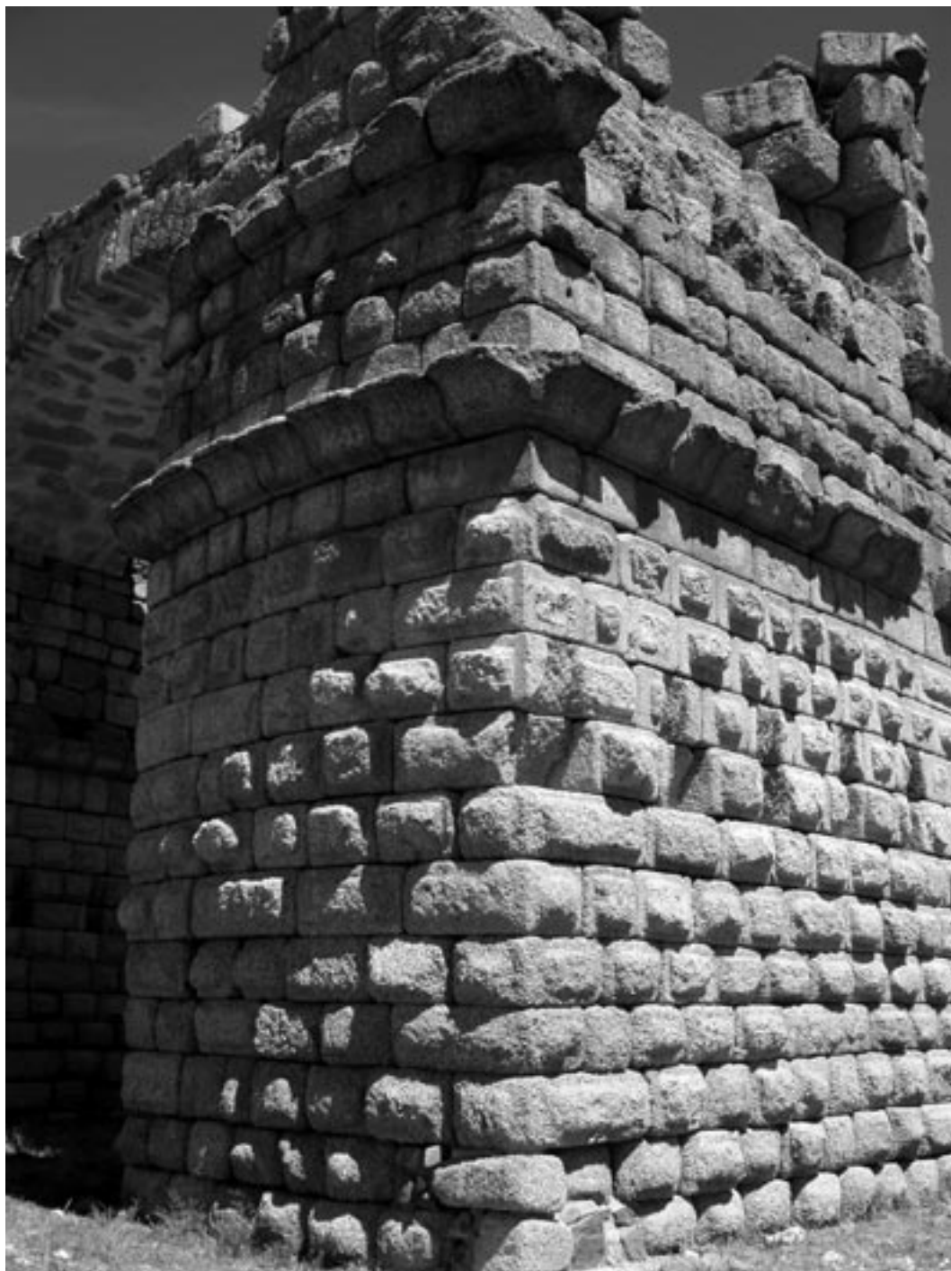
Fig. 11. Puente de Alconétar (Cáceres). Detalle de la curvatura. © Los autores.
