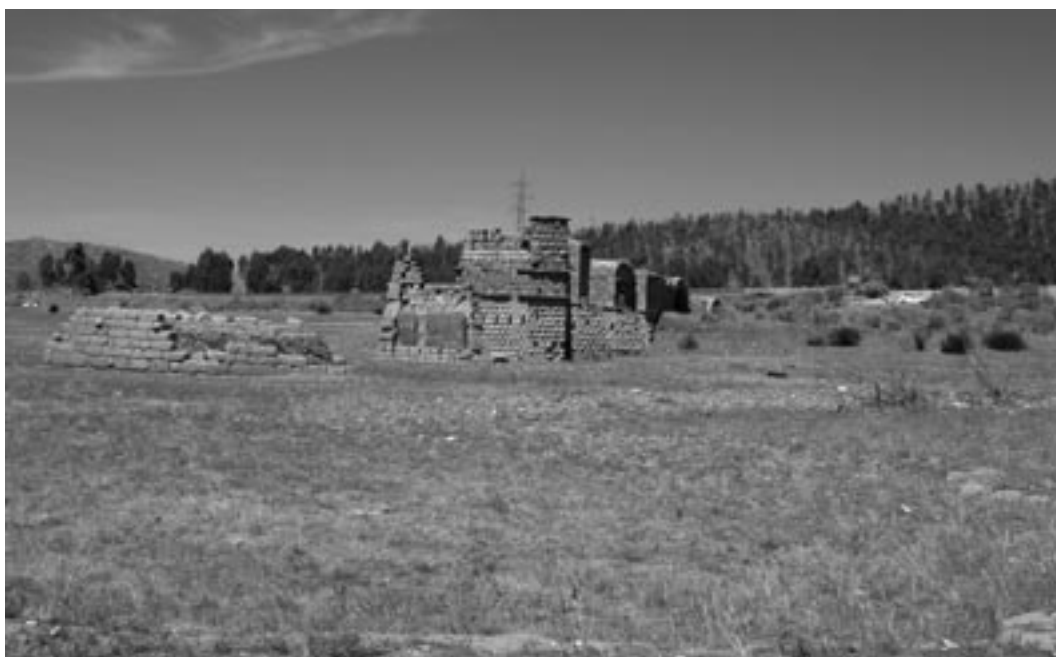
Fig. 6. Restos del Puente de Alconétar, en la actualidad entre Garrovillas y Cañaveral (Cáceres). A la izquierda, la pila conocida popularmente como “mesa del obispo”. © Los autores.
