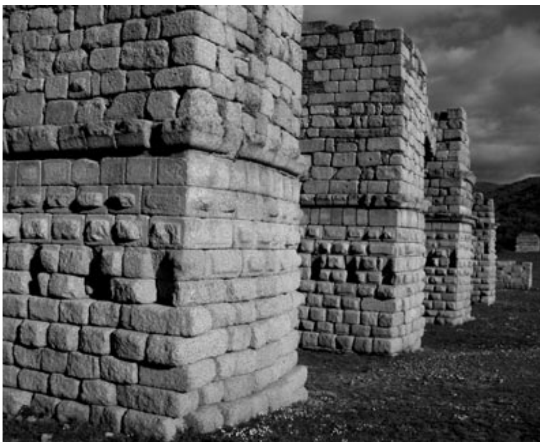
Fig. 8. Puente de Alconétar (Cáceres). Pilares vistos desde la zona que encaraba las aguas abajo del río. Obsérvese la leve curvatura proporcionada a las hiladas de sillares. © Los autores.
