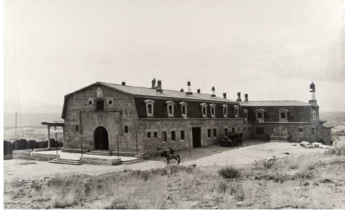
Otto WUNDERLICH, El Parador de Gredos en construcción , 1927-1928.
