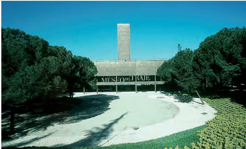
Figura 2. Vista exterior de los jardines y el edificio del Museo del Traje. CIPE.
