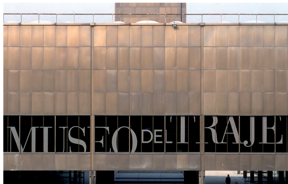
Figura 3. Vista exterior del edificio del Museo del Traje. CIPE.
